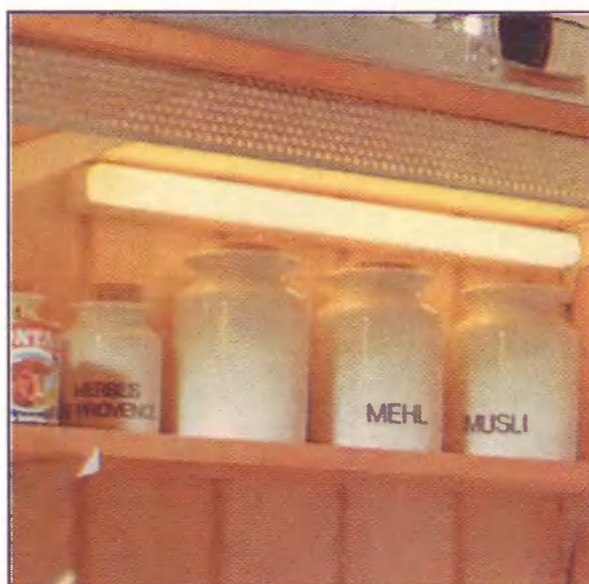
Мягкий свет люминесцентных ламп с кожухом из перфорированного листового металла не слепит глаза.
